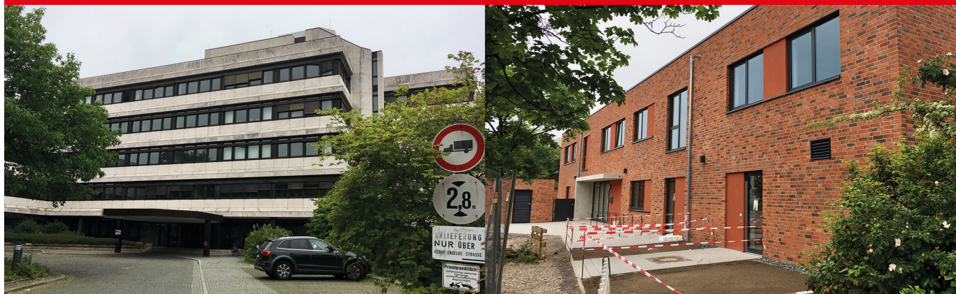
Das alte VHV-Gebäude wird Neubauten mit rund 250 Wohneinheiten weichen. Die neue Kita ist so gut wie fertig.
